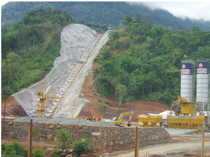
XESET2压力钢管施工
