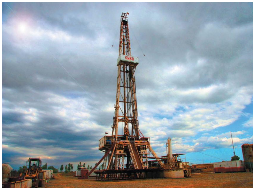
CNPC油田钻井现场
